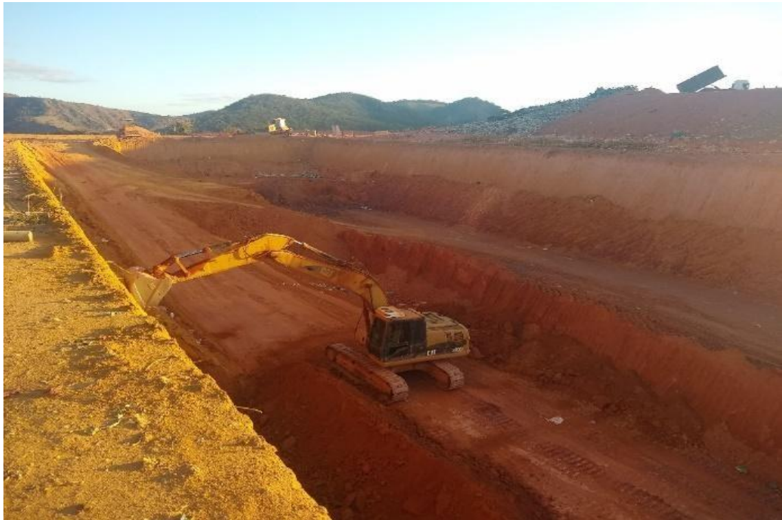
Escavação da célula nº 06.
