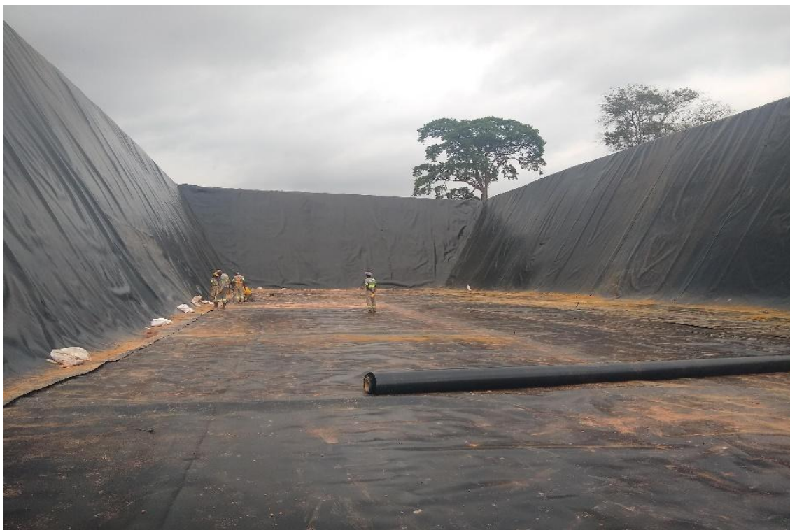
Soldagem da manta de PEAD 2mm na célula nº 06.
