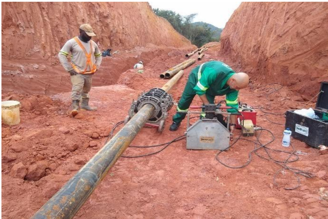
Processo de soldagem da tubulação de PEAD.
