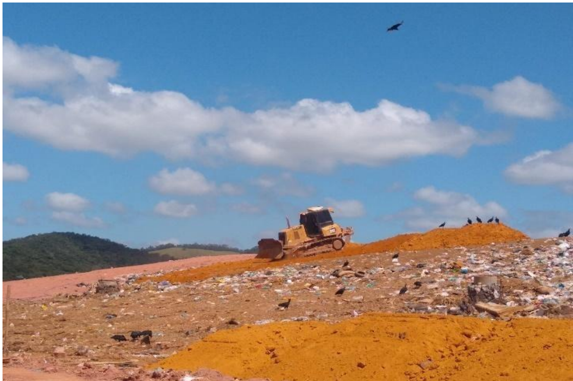
Cobertura de resíduos.
