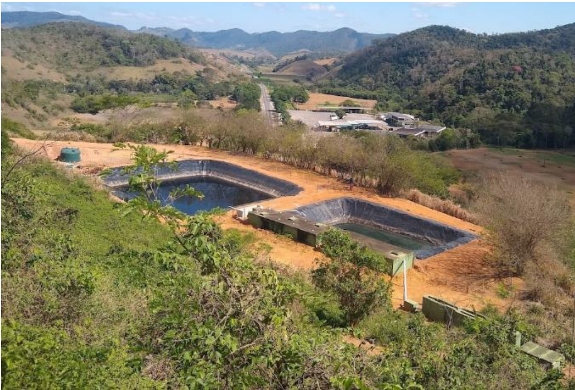
Estrutura da estação de tratamento de efluente (ETE).
